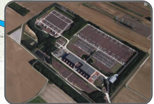
Les Mandarins IFA Substation
